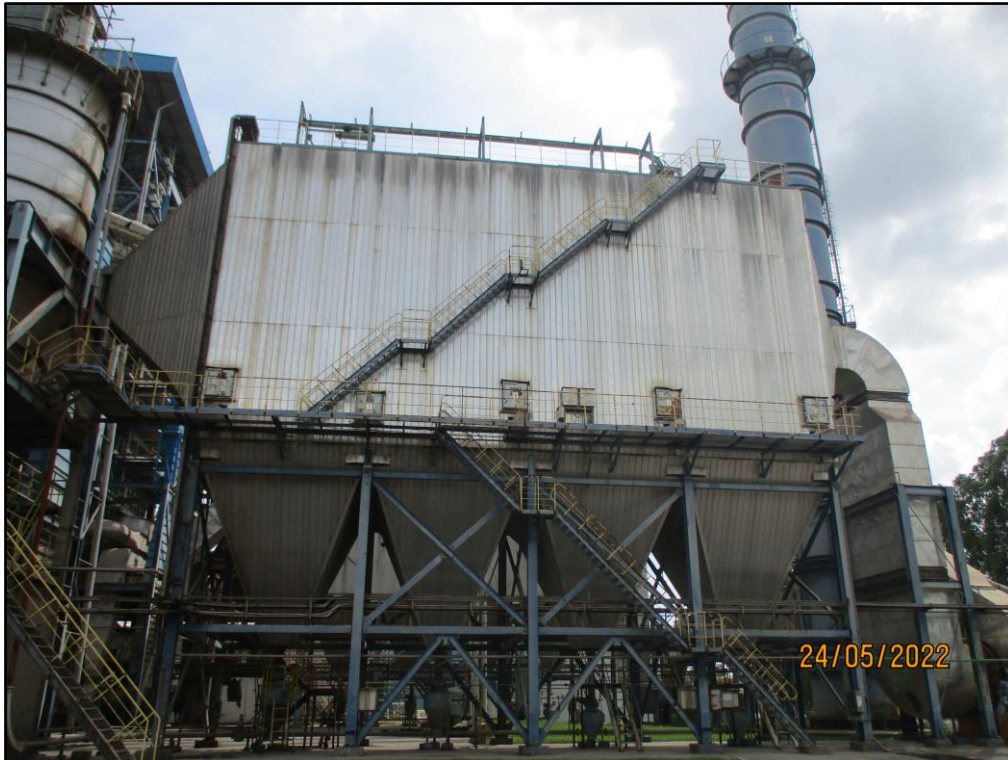
ภาพที่ 1.10 ระบบบำบัดมลพิษทางอากาศแบบไฟฟ้าสถิตย์ (Electrostatic Precipitator; ESP)
